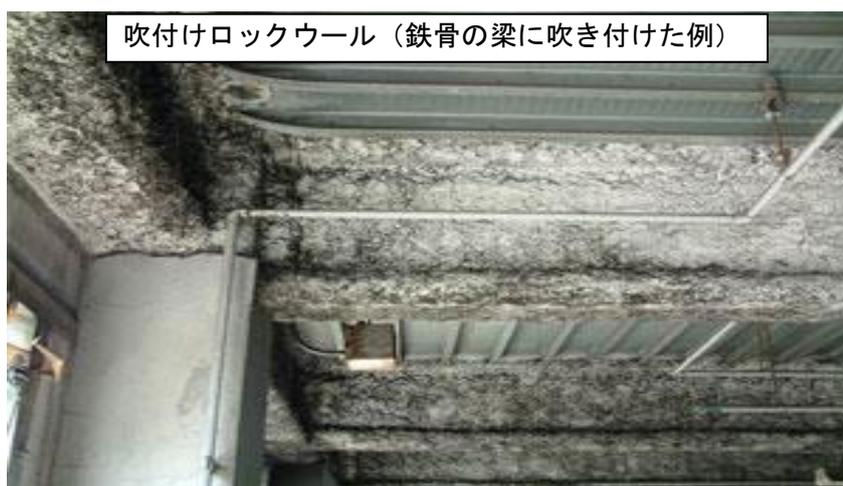
粒状吹付け材：表面に粒状の凹凸が見られる。
