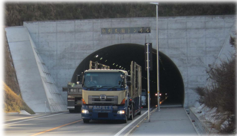
熊野黒瀬トンネル(平成26年3月完成)
