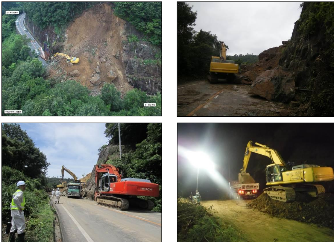
【災害復旧状況】
