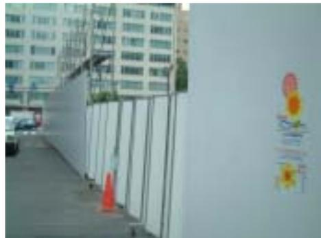
光触媒処理防音パネル
