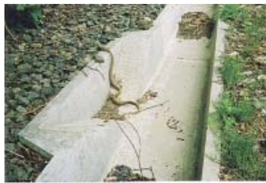
【スロープ付側溝を設置】
