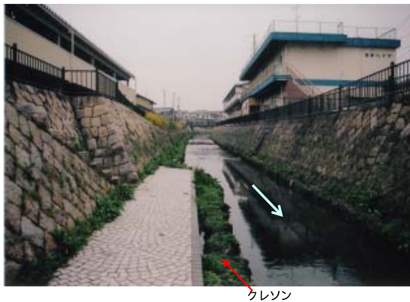
【改修後の写真】
