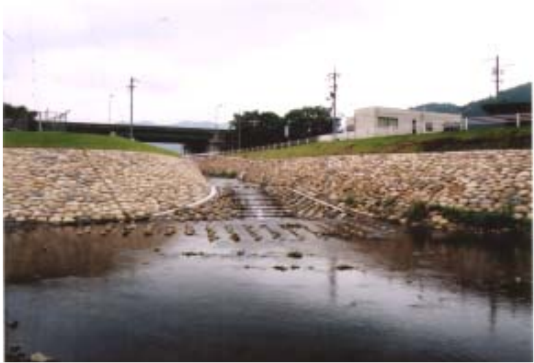
【改修後写真】 支川処理の状況。自然石積工を採用することで周囲の景観に配慮した。
