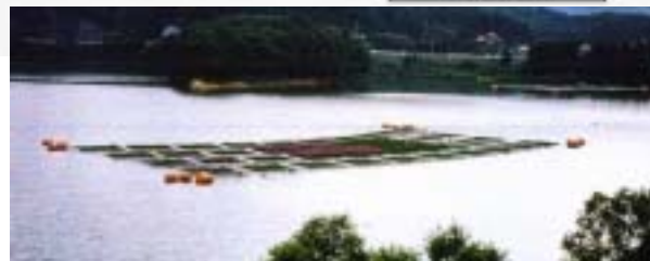
【(1)-ア 植生水質浄化施設】 (イカダパイプ浮き花壇設置状況)
