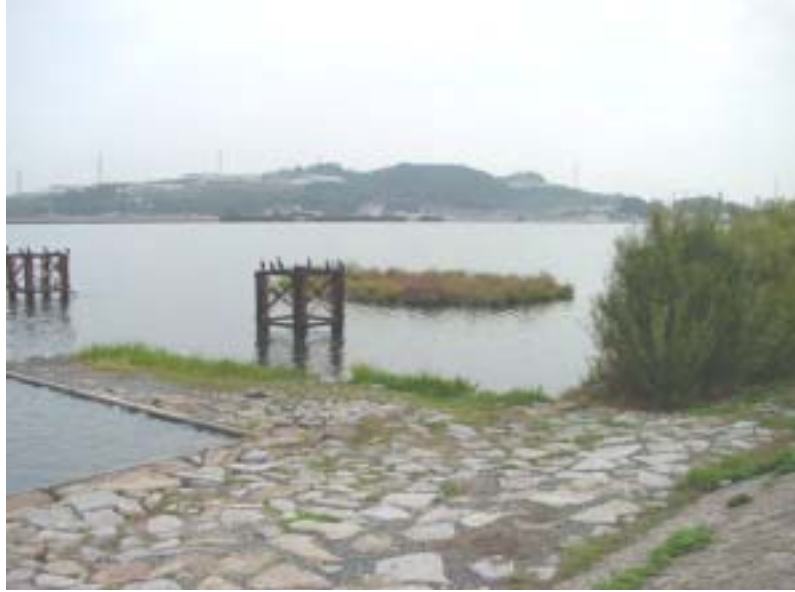
【浮島設置状況】
