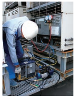
スーパーマーケット冷蔵ショーケース(室外機)からのフロン類冷媒回収の様子 写真提供: 冷媒回収推進・技術センター
