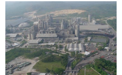
日本環境省の協力によりフロン破壊施設を設置したインドネシアのセメント工場
