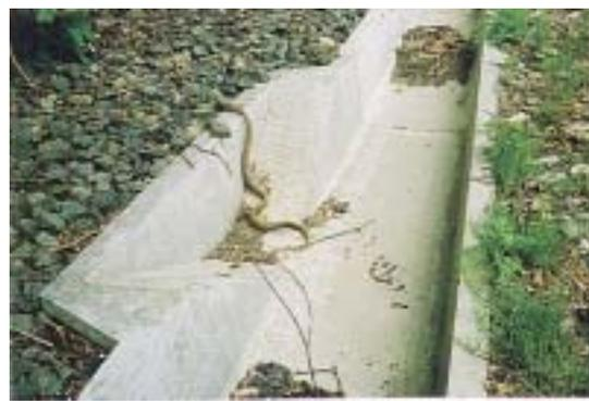
【スロープ付側溝を設置】
