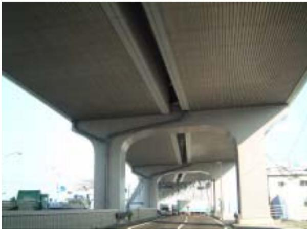
【橋桁に裏面吸音板を設置】
