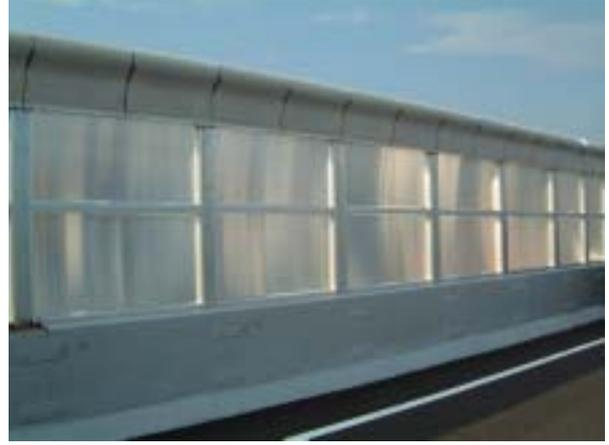
【高架部に先端改良型遮音壁を設置】
