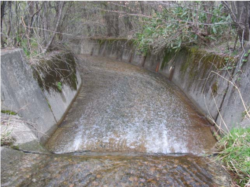
対象区域内を通る三面張り水路の状況
