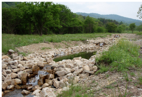
昨年度工事した河川改修工事の状況。 (H21.5.28 撮影)
