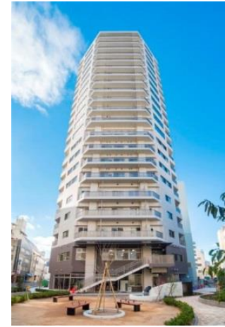
■多様な世代が居住する住宅と高齢者向けサービス施設、子育て関連施設が入居する複合住宅 (京橋地区第一種市街地再開発事業)
