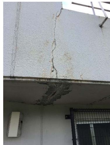
スタジアムの外壁
