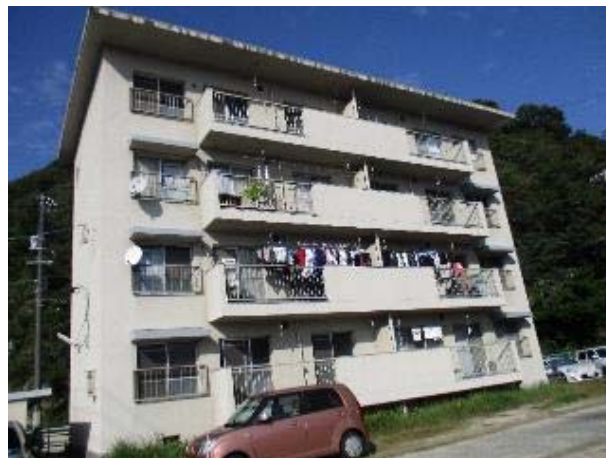
楠那公舎 1 号館（昭和 47 年築）外観
