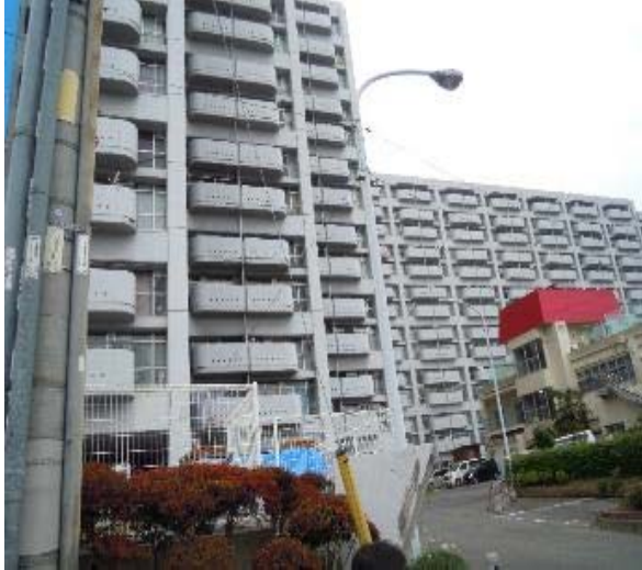
長寿園北高層住宅 広島市中区白島北町所在
