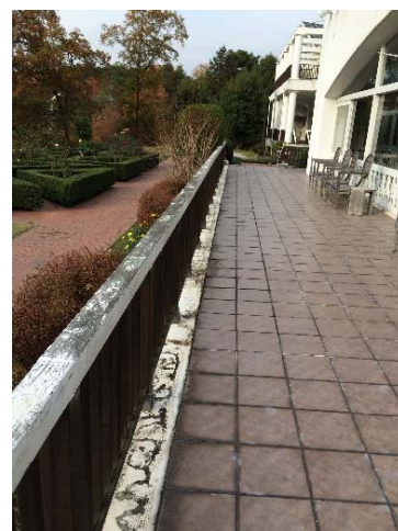
木造手摺部分
