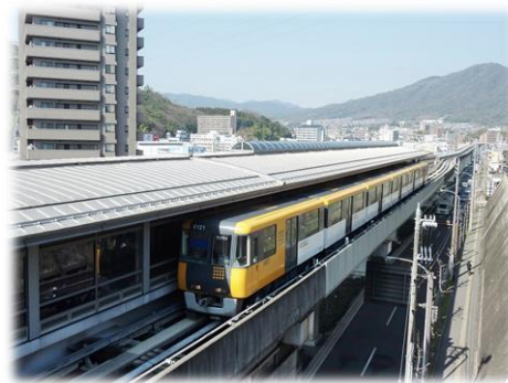
■ アstromラインの開業
