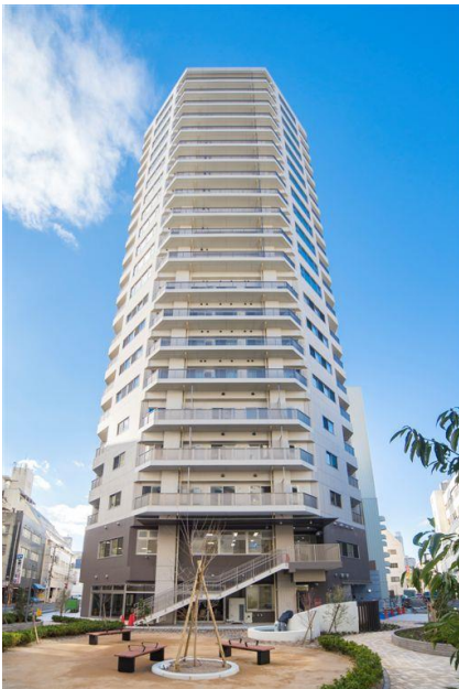
■高齢者世帯やファミリー世帯など多様な世帯が居住する住宅と高齢者向けサービス施設、子育て関連施設が入居する複合住宅（京橋町地区第一種市街地再開発事業）
