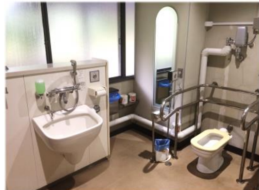
■施設のバリアフリー化（オストメイト対応トイレ）
