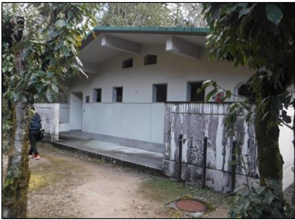
【写真⑤】 ⑤トイレ2（撤去⇒新設）
