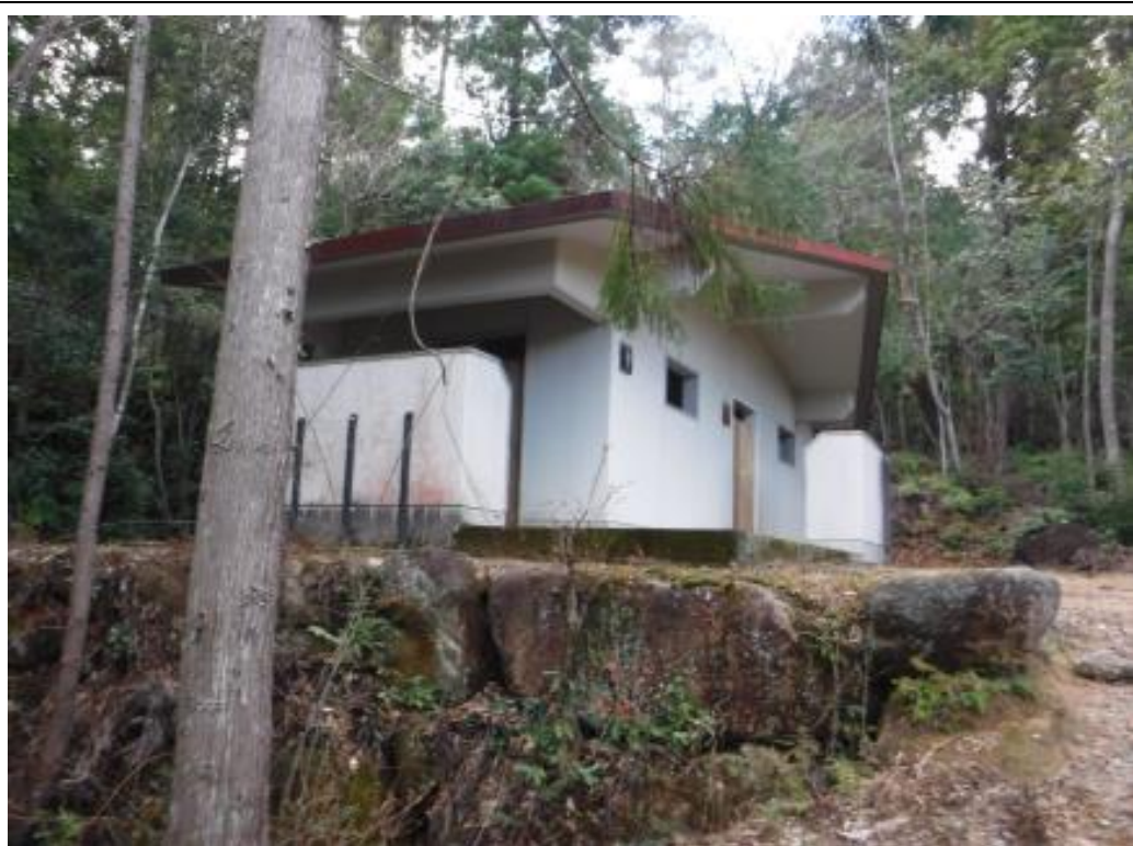
【写真①】 ⑥公衆用便所（撤去）
