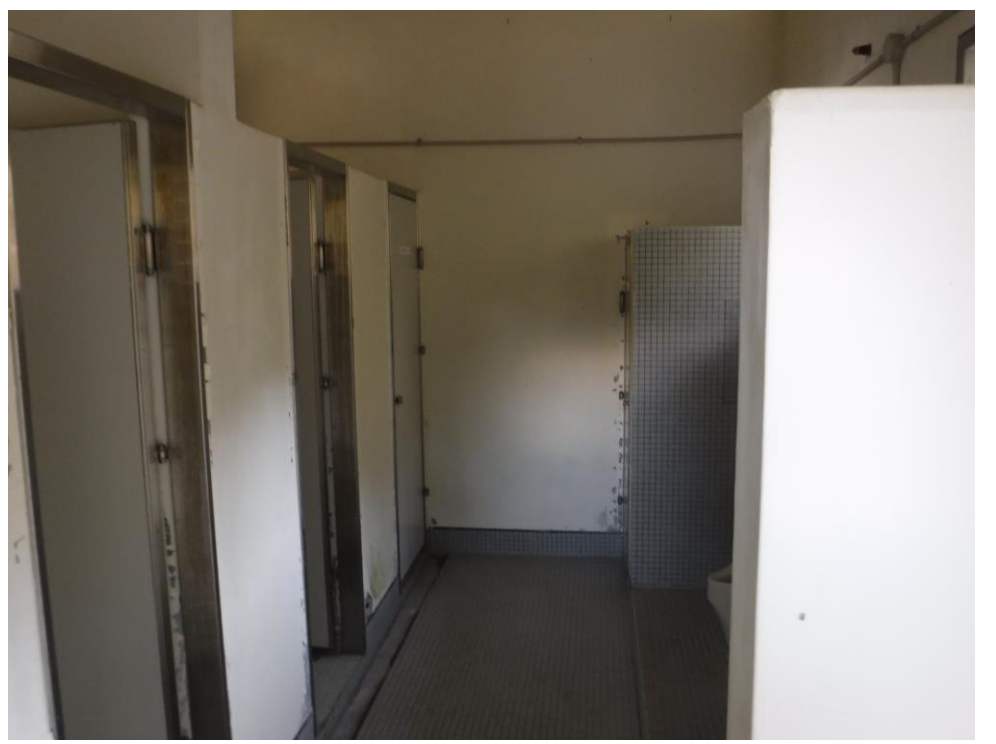
【写真⑥】 ⑤トイレ2（撤去⇒新設）（内観）
