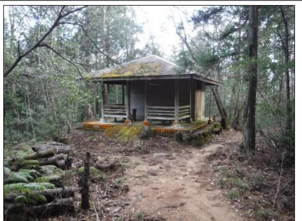
【写真②】 ⑦公衆用便所（撤去）
