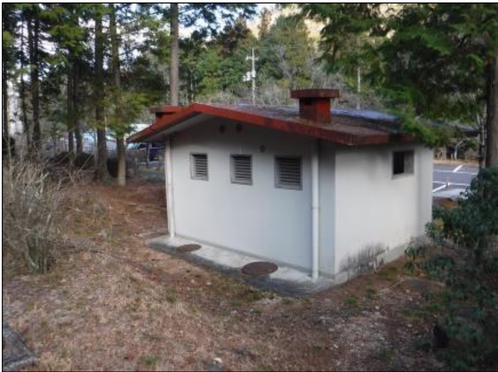
【写真⑦】 ③トイレ2（撤去⇒新設）
