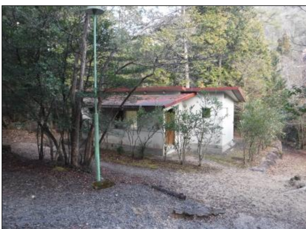
【写真③】 ④公衆用便所（撤去）
