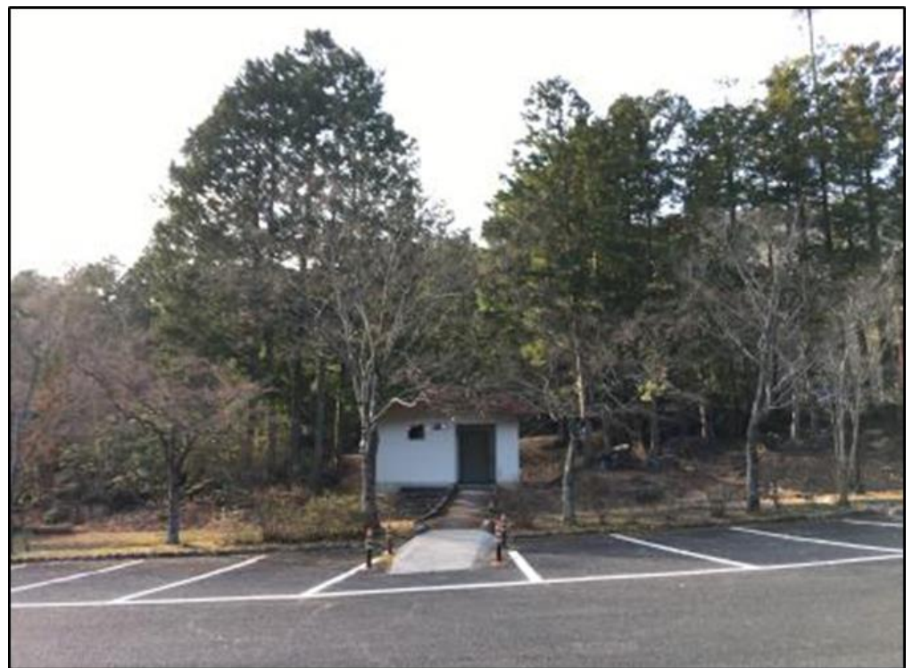
【写真⑧】 ③トイレ2（撤去⇒新設）
