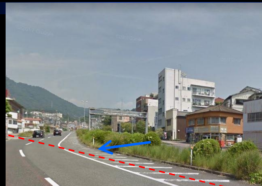
土石流の下流端の確認
