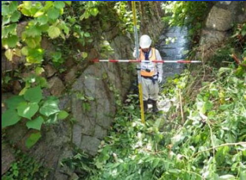
斜面の断面の確認
