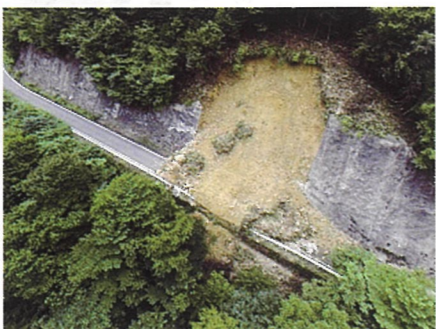
図3 ドローンで空撮した現場
