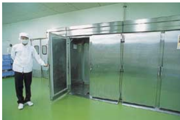
この冷蔵庫には壁の裏の部屋からのみ食材が入られ、こちら側で取り出して盛り付けに回す「一方通行」が確保されています
