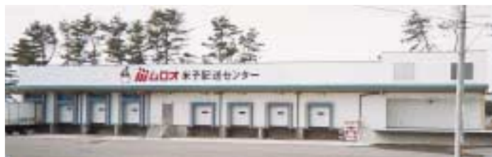
米子配送センター
