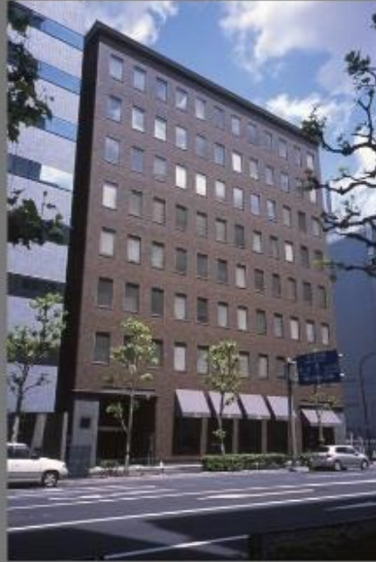
村野藤吾 森五商店東京支店(現・近三ビル) 1931年
