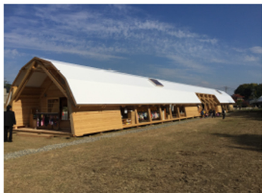
仮園舎の外観
