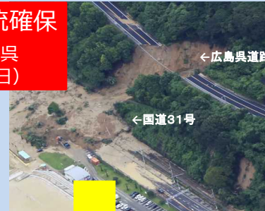
国道31号 (坂町水尻)
