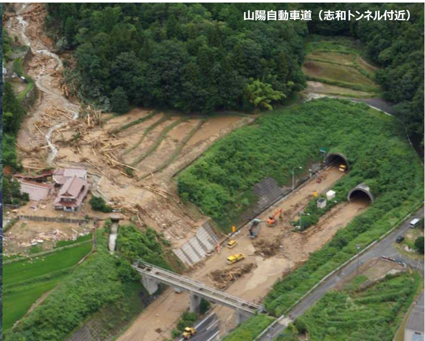
広島呉道路（安芸郡坂町水尻）
