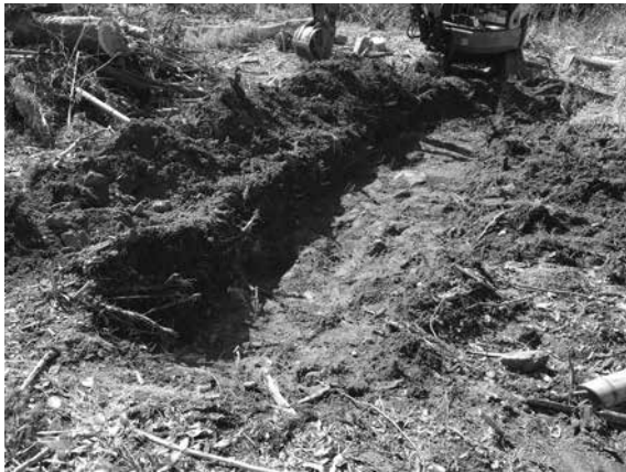
c 6 T (北東から)
