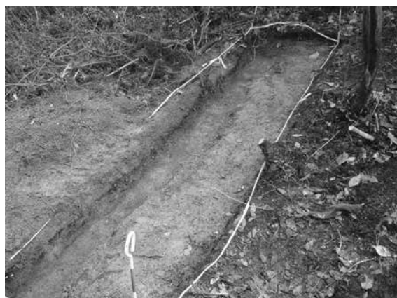
h 工事用道路 (西から)
