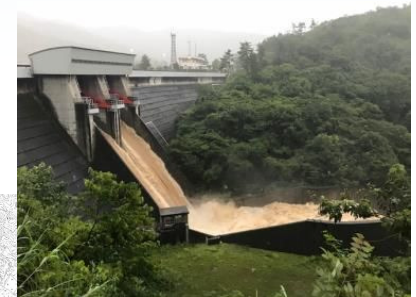
棕梨ダム放流状況
