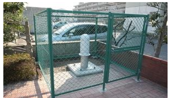
広島県西部厚生環境事務所に設置されているモニタリングポスト（廿日市市）
