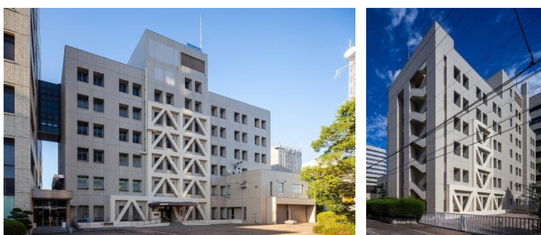
耐震補強された本館の外観。写真左が正面（北面），右が南面。いずれの写真でも建物中央の白く見える部分が補強箇所
