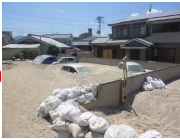
【写真左・中】大屋大川(呉市)：大量の土砂・流木が河道内に堆積し，河道が埋塞し，住宅地には氾濫した土砂が大量に堆積
