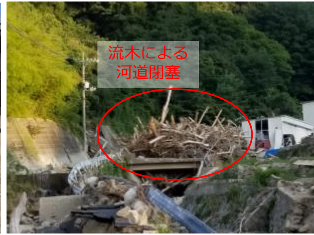
【写真左・中】大屋大川(呉市)：大量の土砂・流木が河道内に堆積し，河道が埋塞し，住宅地には氾濫した土砂が大量に堆積
