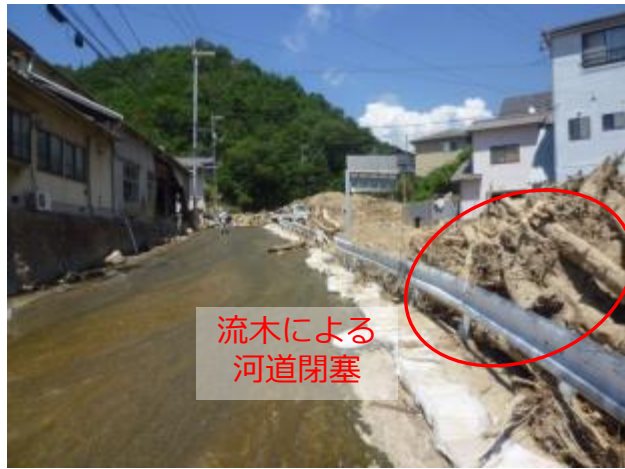
【写真左・中】大屋大川(呉市)：大量の土砂・流木が河道内に堆積し，河道が埋塞し，住宅地には氾濫した土砂が大量に堆積
