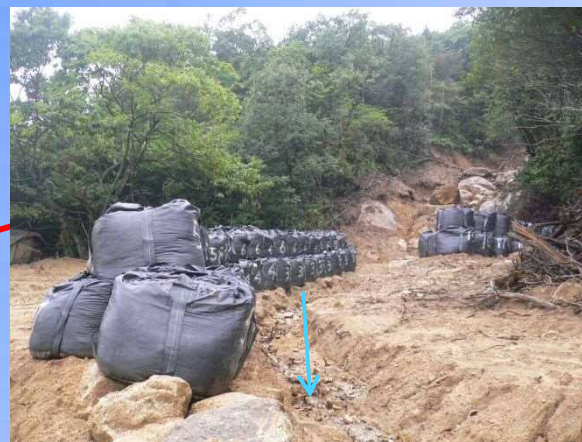
応急対策工：大型土のう
