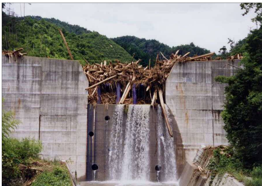
砂防堰堤工の事例
