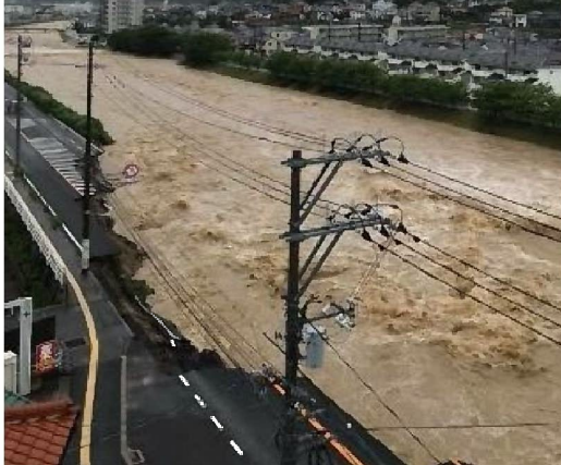
②瀬野川左岸 国道2号崩落状況
