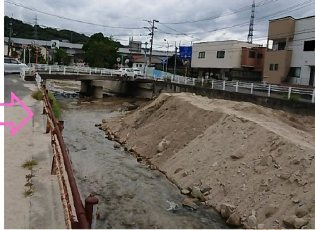
③瀬野川左岸 国道2号崩落状況
