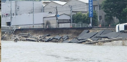
③瀬野川左岸 国道2号崩落状況
