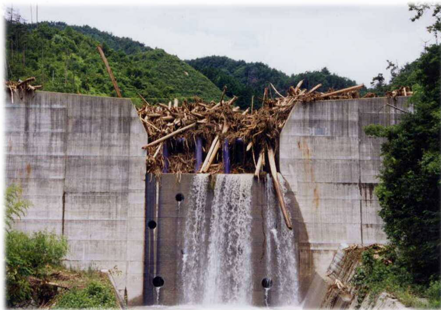
砂防堰堤工の事例
