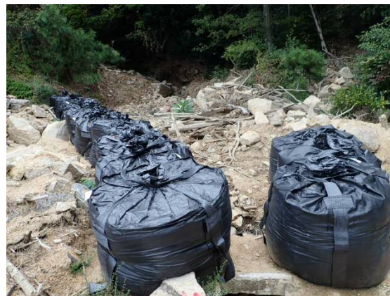
大型土のう設置状況
