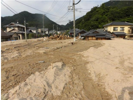
【呉環状線（天応地区）：発災直後】
