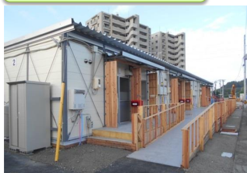
【平成ヶ浜中央公園応急仮設団地（坂町）外観】
