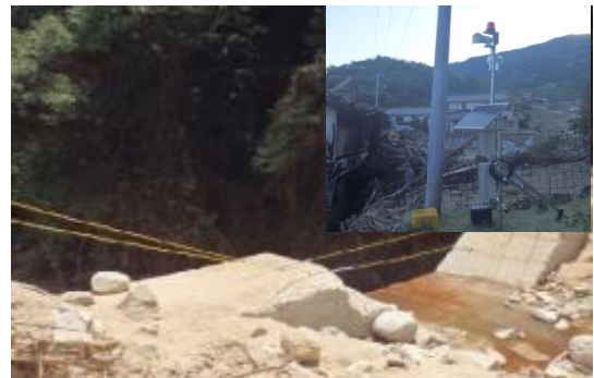
【木原地区：8月時点】 土石流センサー
