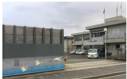
【本郷取水場防潮扉：嵩上げ後（h=3m）】
