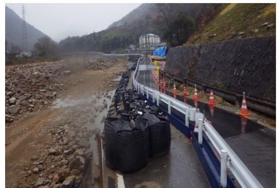
【椋梨川発電所前：10月末完成】
