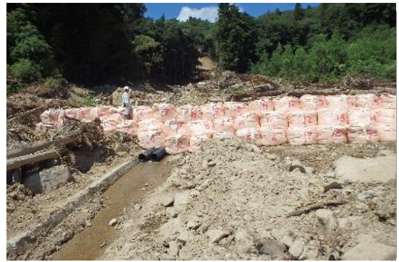
【大型土のう設置状況 8月時点（呉市）】
