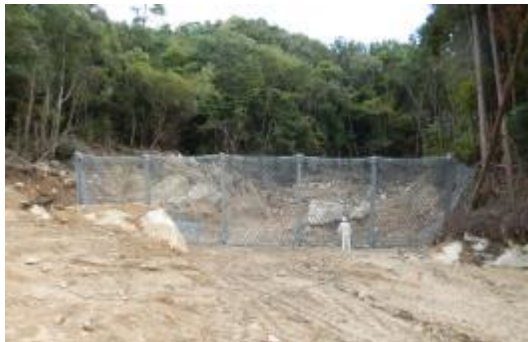
【川角地区：10月時点】 ワイヤーネット
