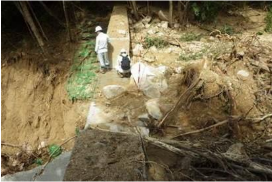
【緊急点検実施状況 8月時点（東広島市）】
