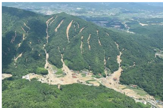
【被災直後の様子（呉市安浦町市原地区）】
