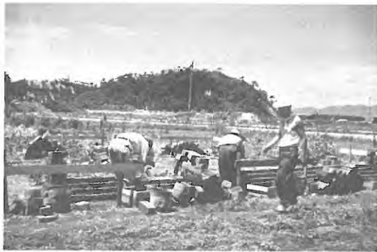
22 レンガで基礎をつくる
