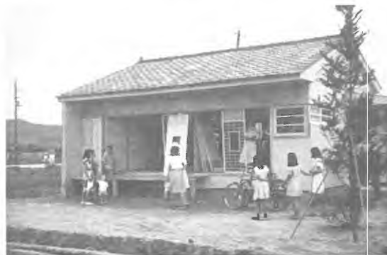
28 建具の取付け
