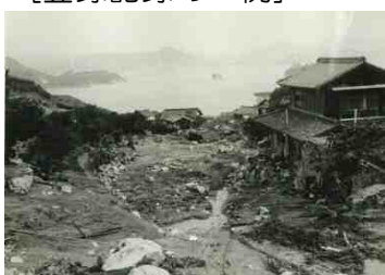
昭和42年豪雨災害 [三原市木原3丁目] (提供：東部建設事務所三原支所)
