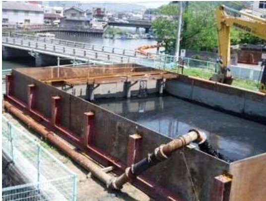
河床浚渫状況 (手城川排水機場付近)
