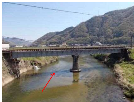
改修に伴い架替を要する JR 鉄道橋梁
