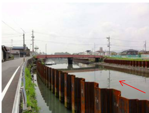
東手城工区 (三つ橋全景)
