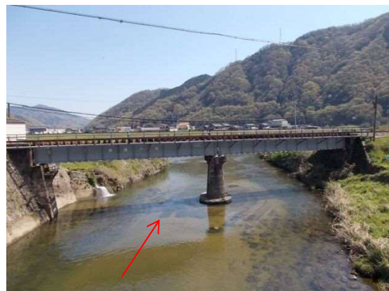
改修に伴い架替えを要する JR 鉄道橋梁
