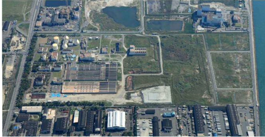
芦田川浄化センター（福山市箕沖町）
