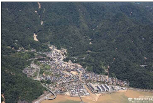
坂町小屋浦地区
