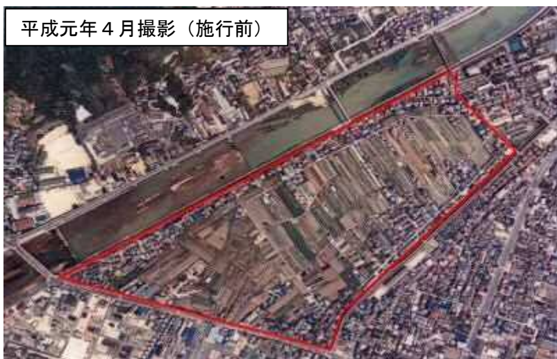
平成27年10月撮影（施行後）
