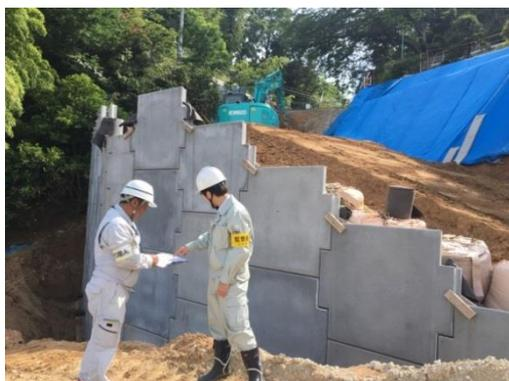
本現場へのアクセスは、県道（幅員 2.1m 程度）・私有地（幅員 1.9m 程度）と狭く資機材の搬入及び発生残土処理・コンクリート殻処理に苦勞しました。背面掘削（勾配 1:0.5）時期が降雨量の多い時期と重なり、二次被害等の安全面にも配慮が必要でした。
