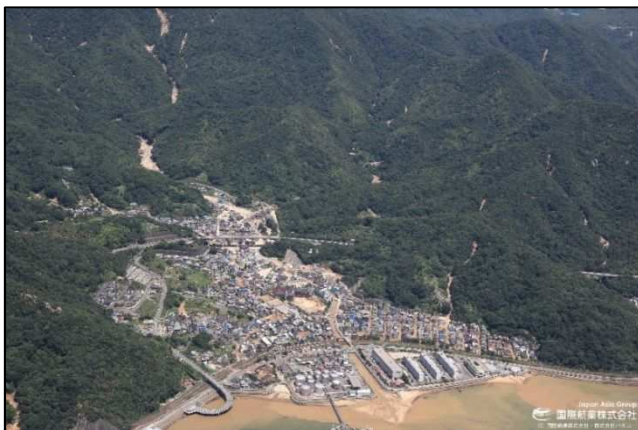
坂町小屋浦地区
