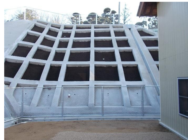
工事完了（令和2年1月31日）
