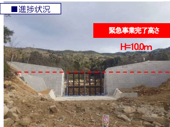
工事完了（令和2年2月12日）
