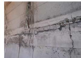
水平目地部付近の浮き(御調トンネル)
