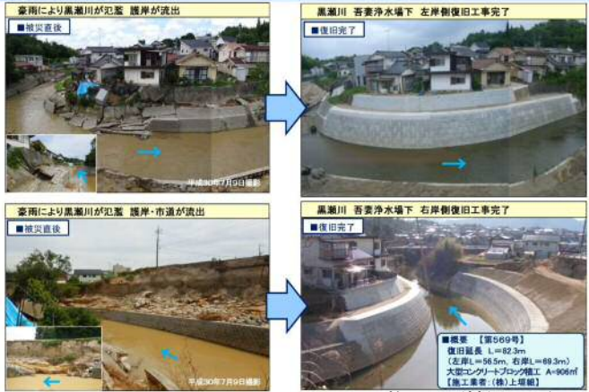
施工：(株)上垣組
