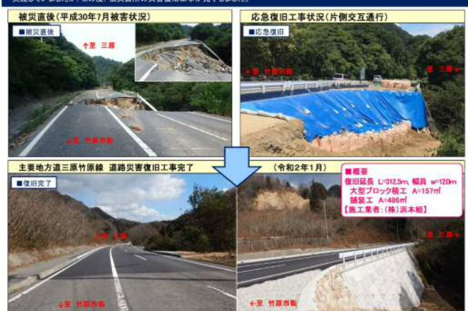
施工：(株)浜本組
