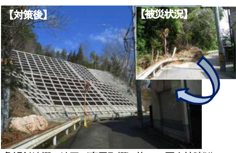
急傾斜地郷5地区(高屋町郷) 施工：国土技建棟
