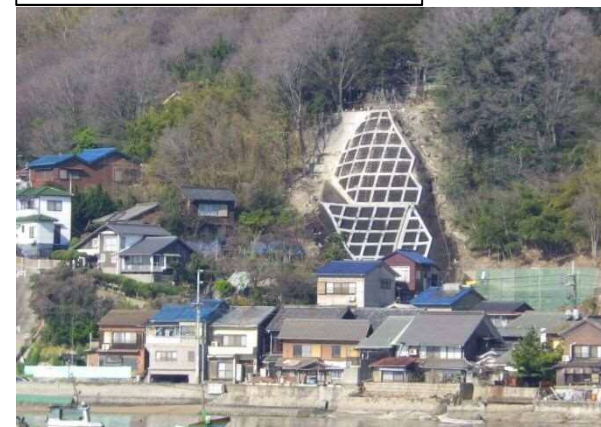
工事完了(令和2年3月27日)
