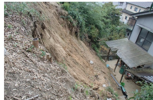
斜面崩壊・被災状況（H30年7月）
