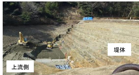
ため池の改修状況
