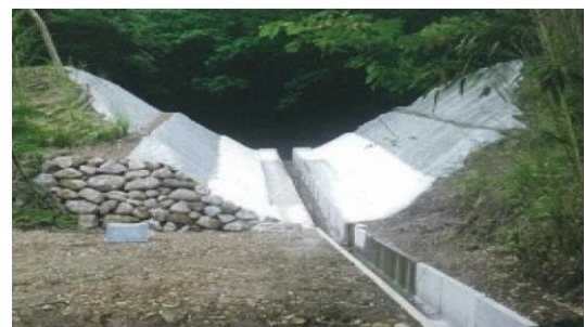
ため池の廃止工事
