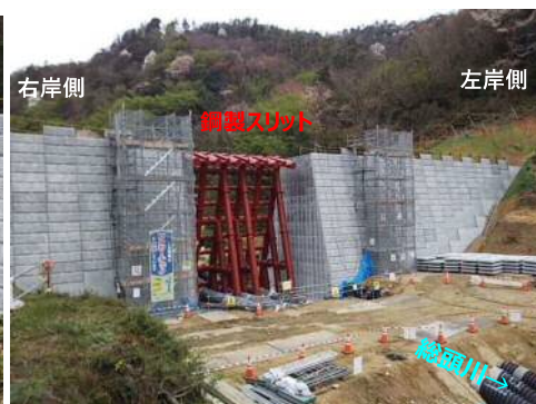
総頭川施工状況 (右岸側より)
