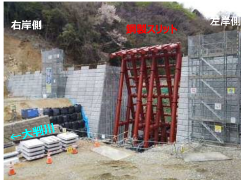
大判川施工状況 (右岸側より)
