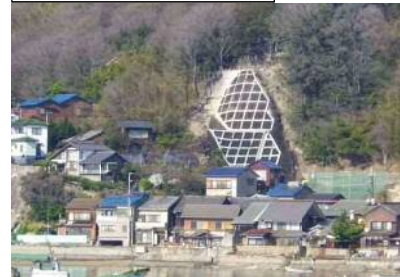
工事後（令和2年3月27日）
