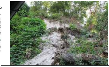
斜面崩壊・被災状況（H30年7月）
