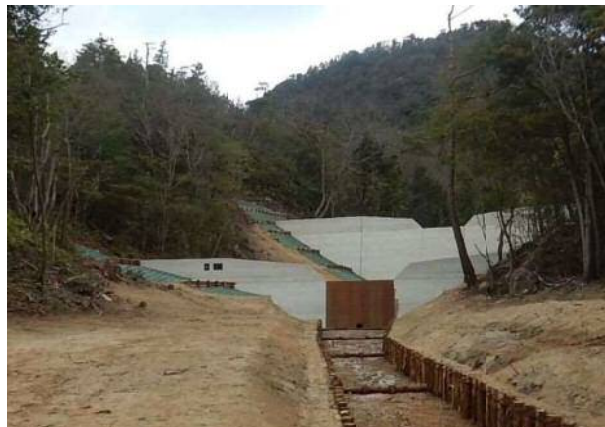
【治山ダム完成状況】
