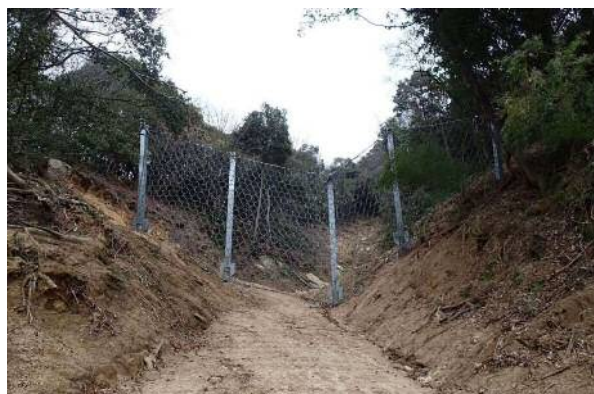
【土石流安全対策工 完成状況】
