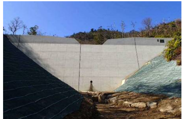
【治山ダム完成状況】
