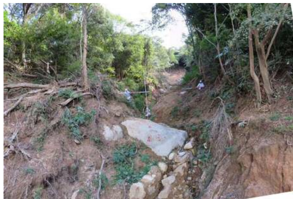
【工事前の荒廃状況】
