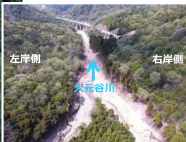
着手前(上流から撮影)
