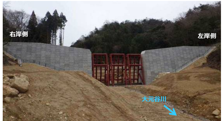
堰堤施工状況(下流側より)
