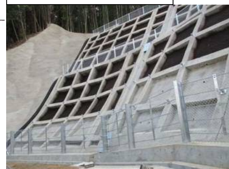
工事完了（令和2年3月27日）
