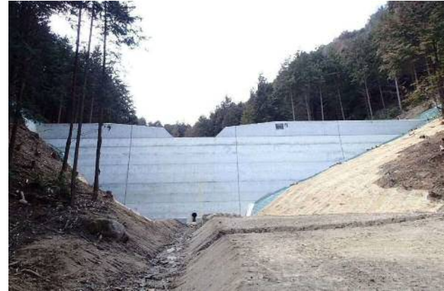
【治山ダム完成状況】
