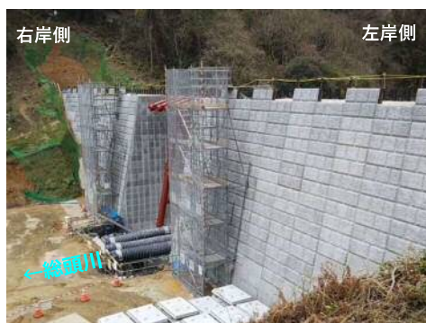
総頭川施工状況 (左岸側より)
