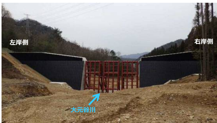
堰堤施工状況(上流側より)
