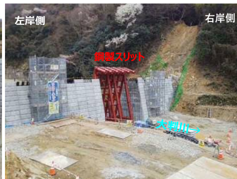
大判川施工状況 (左岸側より)
