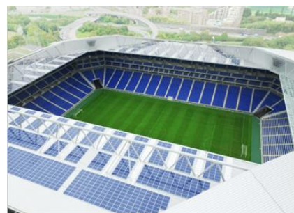
屋根に太陽光発電設備 (パナソニック(株)公式サイト)
