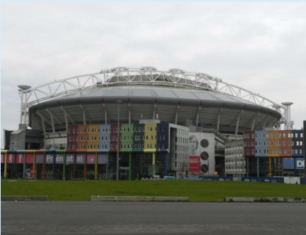
スタジアム外観 カラフルな各種複合施設がスタジアムに併設。
