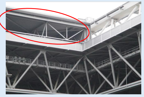
開閉式の屋根 屋根を閉じて展示場として使用することもある。
