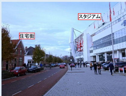
スタジアム外観 住宅街が近接。
